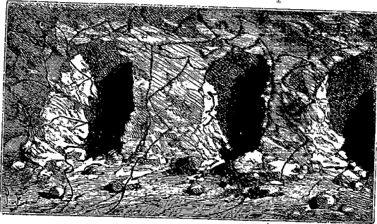
Disposition des fils électriques dans les galeries sous-marines de Hell-Gate.
